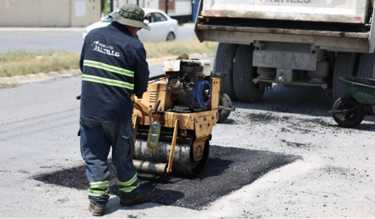
DE MANERA SIMULTÁNEA, el Ayuntamiento de Saltillo realizó trabajos similares en distintos puntos del Bulevar Centenario de Torreón, con el propósito de contribuir a una circulación más segura y eficiente.
