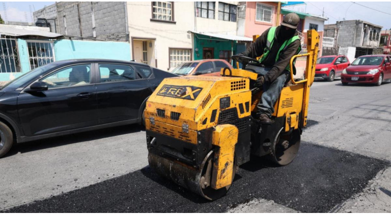
CUADRILLAS DE “Aquí Andamos” realizaron trabajos de rehabilitación de diversos tramos de pavimento deteriorado en calles de la Colonia El Toreo.
