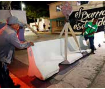
PERSONAL DE “AQUÍ Andamos” llevó a cabo labores de reacomodo y sustitución de muros de contención de concreto sobre el Bulevar Fundadores en horario nocturno.
