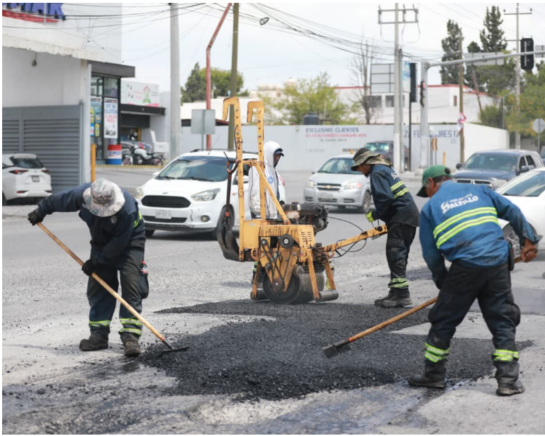
SE ATIENDEN TRAMOS de pavimento deteriorado en el Bulevar Fundadores, Real de Peña, La Minita y otras vialidades estratégicas de Saltillo.
