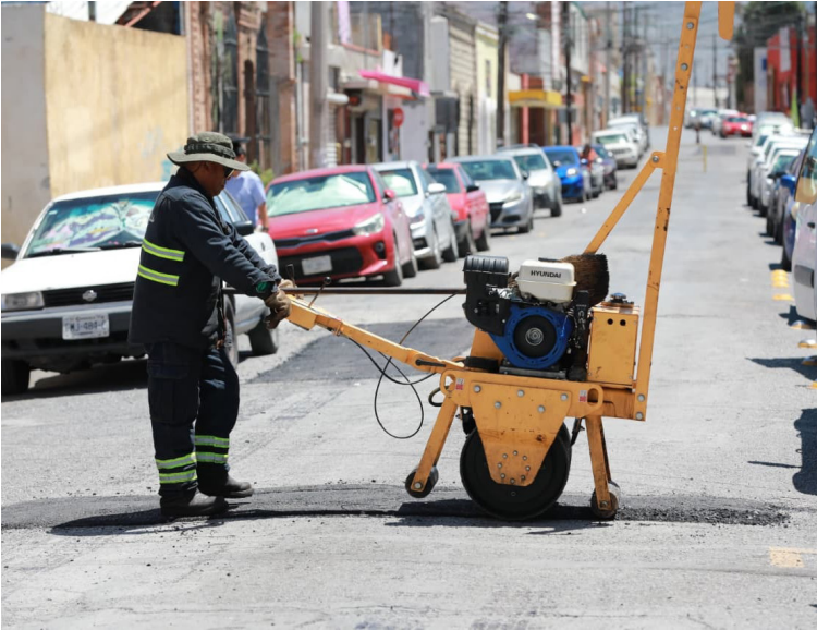
SALTILLO REFUERZA REHABILITACIÓN de carpeta asfáltica.
