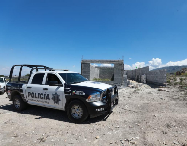
“LA ESTRATEGIA DEL Alcalde Javier Díaz es la de prevenir la expansión de asentamientos irregulares y construcciones que carecen de los permisos y licencias correspondientes”, señaló la Directora de Desarrollo Urbano Nayeli Castro.
