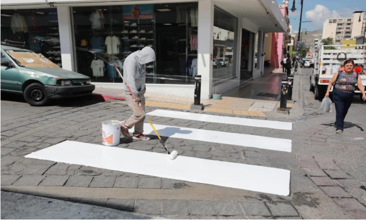
PERSONAL DE “AQUÍ Andamos” realiza trabajos de delimitación y renovación de los diferentes pasos peatonales ubicados sobre la Calle Guadalupe Victoria, en el Centro Histórico.
