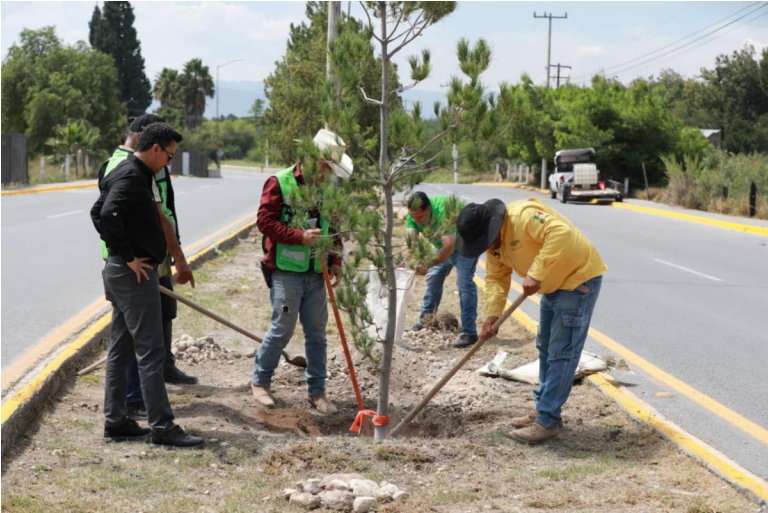
PERSONAL DE MEDIO Ambiente y Desarrollo Sustentable realiza trabajos de reforestación con arbolado de la especie pino piñonero en el camellón central del Bulevar José Musa de León.
