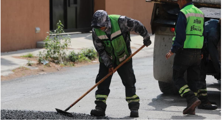
CUADRILLAS DE “AQUÍ Andamos” rehabilitaron diversos tramos de pavimento dañado sobre la Calle Guadalupe Victoria, entre las calles Ignacio Allende y Guillermo Purcell, en el Centro Histórico.
