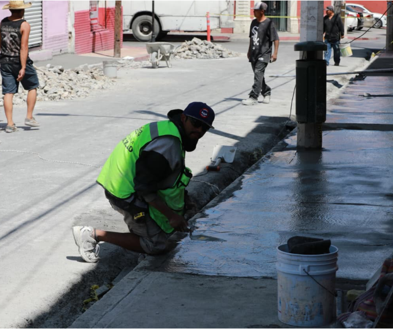
COMO PARTE DEL programa de Rehabilitación de Banquetas, se trabajó en las aceras poniente y oriente de la Calle Ignacio Zaragoza, entre Juan Aldama y Manuel Pérez Treviño, en la Zona Centro.
