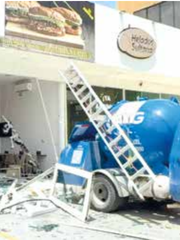
LA EXPLOSIÓN PROVOCÓ daños en ventanales y fachada del negocio, además de afectar locales cercanos por la onda expansiva.
