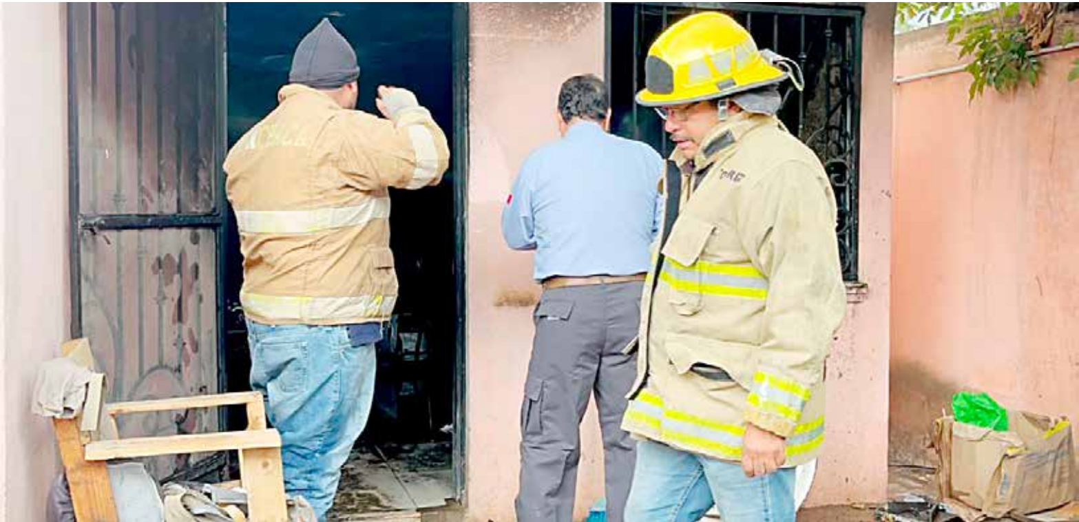
AUTORIDADES DE PROTECCIÓN Civil investigan la falla eléctrica que provocó la rápida propagación de las llamas en el inmueble.
