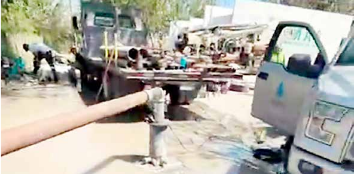
DURANTE LA JORNADA se realizaron las pruebas de bombeo y calibración en el Pozo 9 previo a su entrada en operación regular.
