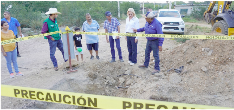
LOS TRABAJOS EJECUTADOS junto al SIMARC contemplan tomas domiciliarias para eficientar el llenado y flujo de agua potable.
