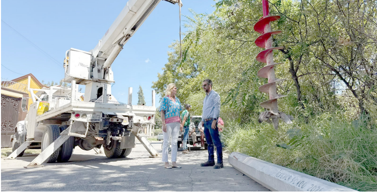
REEMPLAZAN LA UNIDAD de quince kVA por un transformador de cincuenta kVA para garantizar el voltaje doméstico.
