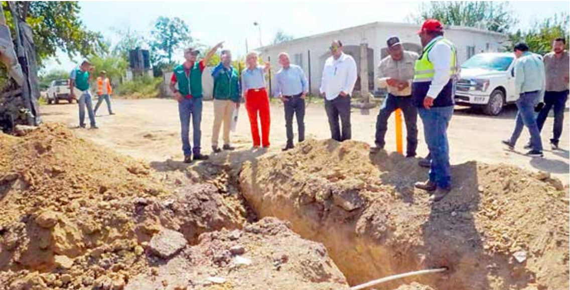
REEMPLAZAN MANGUERA POR tubería de PVC en el Sector Las Azucenas para optimizar el suministro de agua a los hogares.
