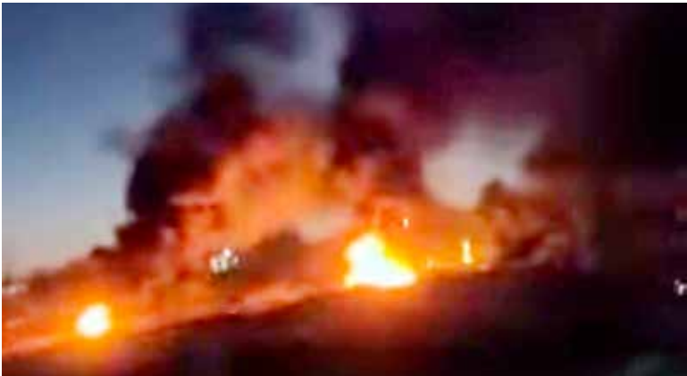
EL FUEGO PROVOCADO en los durmientes de madera afectó el tramo interior del puente.
