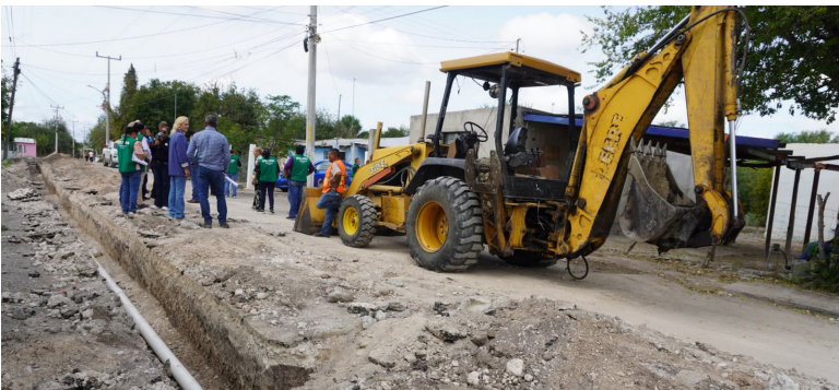
LA OBRA HIDRÁULICA renovará cerca de 2 mil metros lineales de tubería para 750 habitantes.
