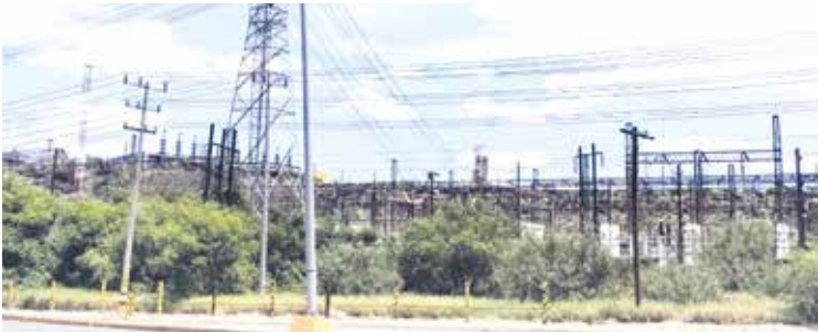
EL TERRENO ESTÁ contiguo a instalaciones eléctricas de CFE, pero la dependencia mantiene en pausa el proyecto Turbo Gas Monclova.
