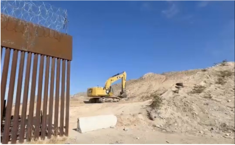
LAS OBRAS DEL muro fronterizo fueron suspendidas temporalmente.
