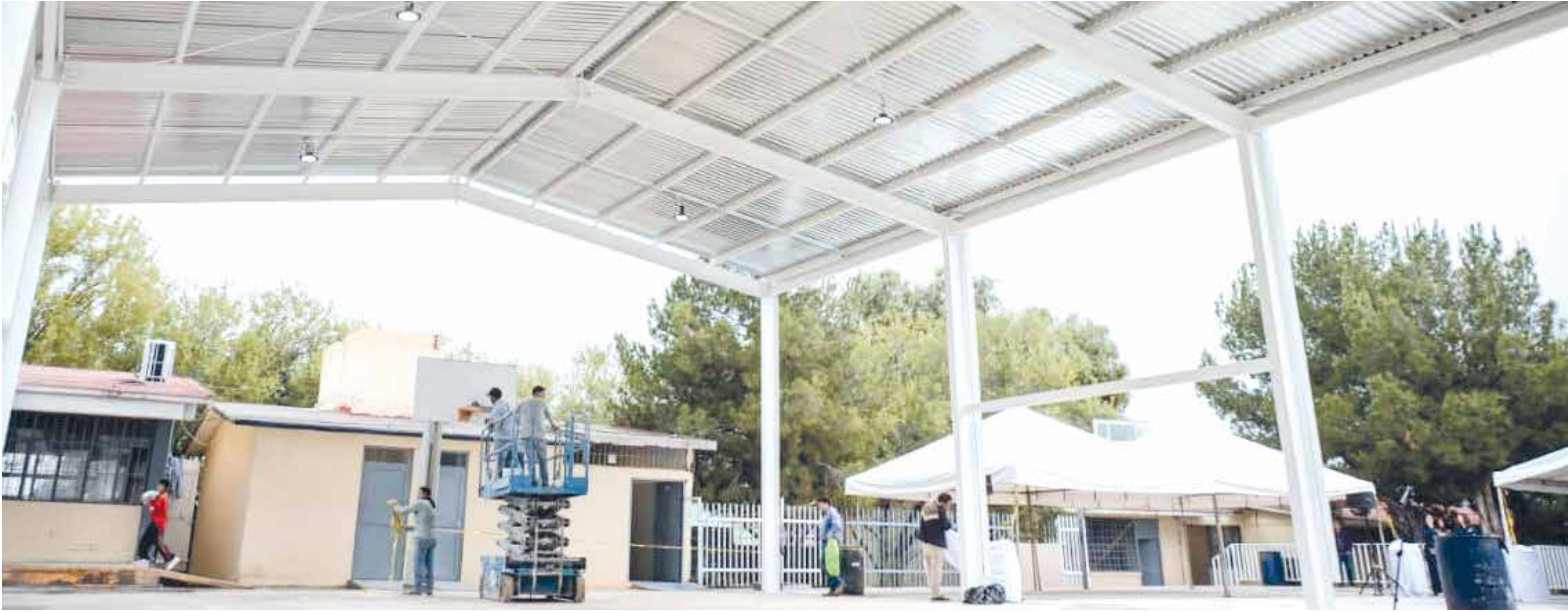
LA TECHUMBRE ES de acero estructural, de 14 por 26 metros, con sistema de bajadas pluviales, instalación eléctrica para iluminación y sistema de pararrayos para protección.
