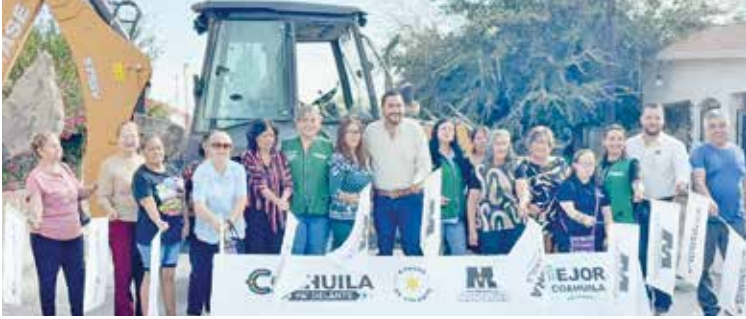
EL ALCALDE CARLOS Villarreal dio el banderazo de arranque a los trabajos de pavimentación de la Calle Itzcoatl, en la Colonia Deportivo, obra que representa una inversión de más de 1.2 millones de pesos.
