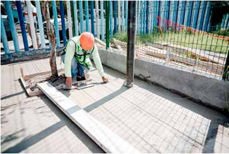
LA CONSTRUCCIÓN SE encuentra en su última fase.
