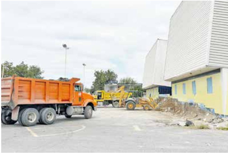
INICIAN DEMOLICIÓN DEL Río Cinemas de Monclova.
