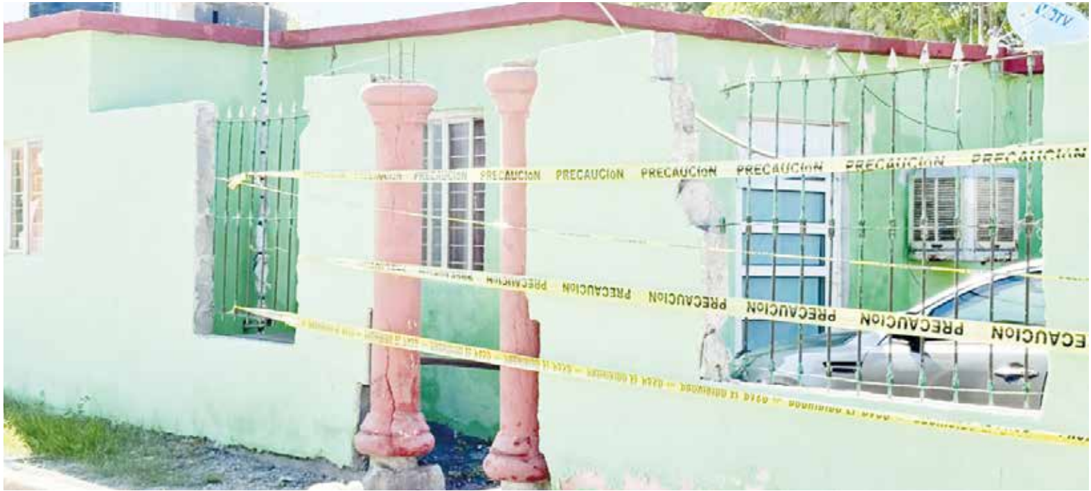
EL HALLAZGO OCURRIÓ en una vivienda ubicada en el cruce de las calles San Antonio y San José.
