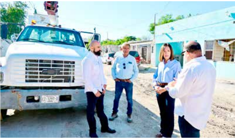
EL PROYECTO INTEGRAL incluye infraestructura eléctrica e iluminación para transformar el entorno urbano de las familias en la colonia Diana Laura.
