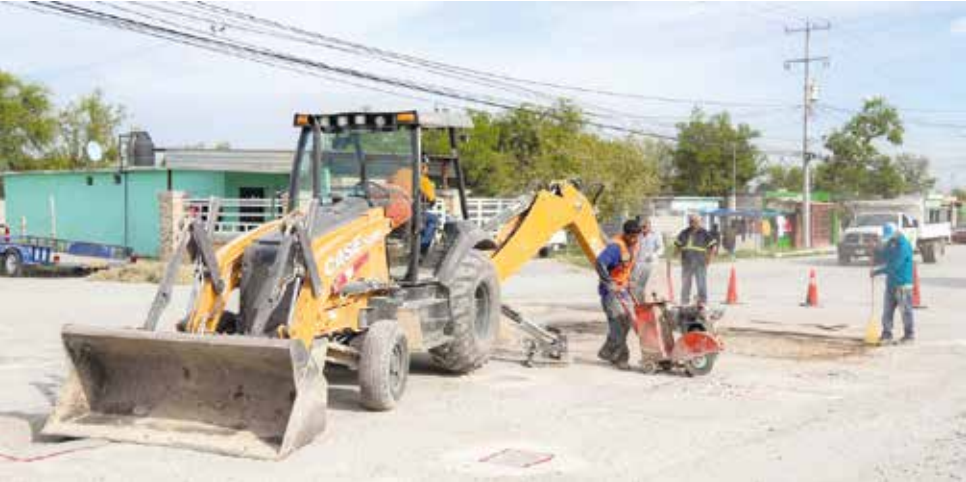
LOS TRABAJOS ARRANCARÁN en avenidas principales y continuarán en calles secundarias.
