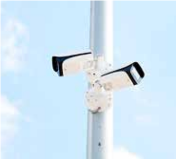
LAS CÁMARAS DE seguridad quedaron instaladas en el kilómetro 13.5 de la carretera Parras - Paila.
