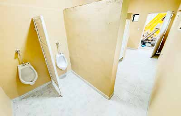
ALCALDE ENTREGÓ BAÑOS rehabilitados y reconocimientos a trabajadores sindicalizados.
