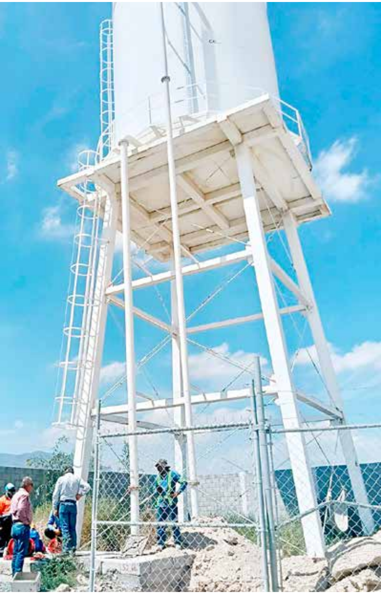
NICANOR AGUIRRE FLORES , explicó que el mantenimiento preventivo de los pozos permite revisar y atender oportunamente los equipos para mantener en operación las fuentes de abastecimiento y reducir el riesgo de fallas.
