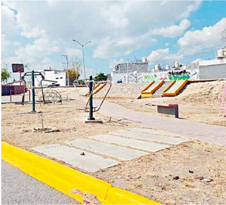
“ESTAMOS AVANZANDO Y vamos a continuar hasta completar los trabajos que necesita la colonia. Lo importante de este programa es que no se trata de venir un solo día, sino de mantener a nuestros equipos trabajando”, dijo el Alcalde Tomás Gutiérrez.
