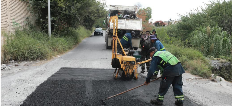
AYUNTAMIENTO DE SALTILLO refuerza trabajos de rehabilitación vial.
