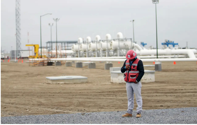
GASODUCTO LOS RAMONES , municipio ubicado al oriente de Monterrey, Nuevo León.
