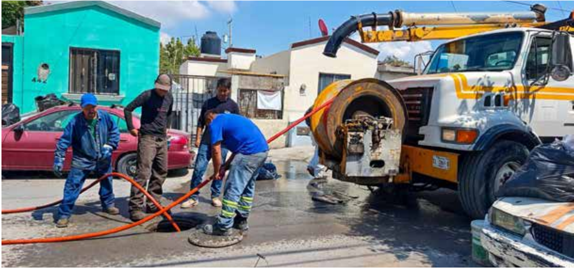
EMAS, MANTIENE TRABAJOS de reparación, mantenimiento y atención a reportes ciudadanos en distintos sectores de la ciudad, con el objetivo de mejorar el funcionamiento de las redes de agua potable y drenaje sanitario.
