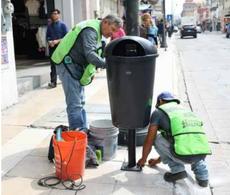
EL GOBIERNO MUNICIPAL continúa con la instalación de botes de basura sobre las aceras de la Zona Centro.
