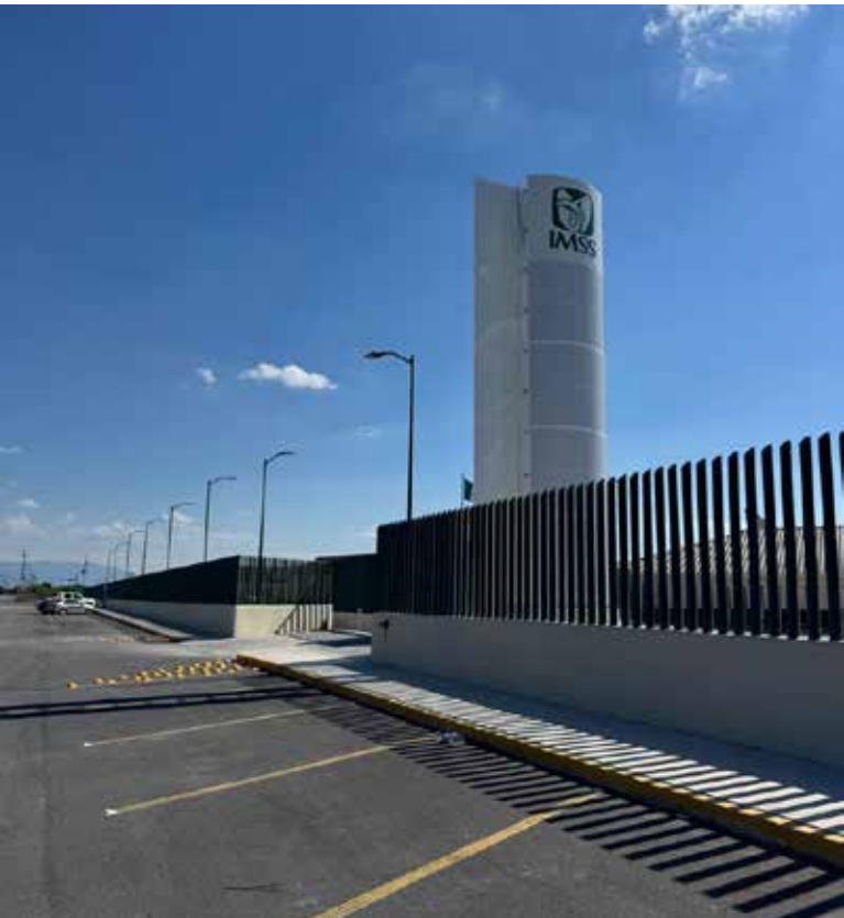
LA INSTALACIÓN DE aparatos médicos forma parte de los preparativos para iniciar operaciones.
