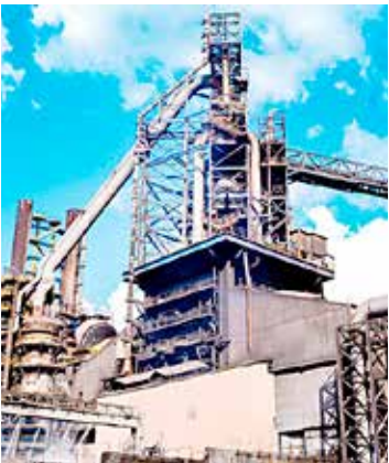
LA AUTORIDAD JUDICIAL les concedió a Cargill y Afirme, un plazo que vencerá a mediados de enero de 2027, para concretar un consorcio capaz de adquirir AHMSA y MINOSA.
