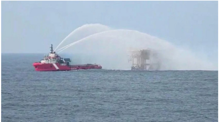
A LAS 11:15 HORAS se registró fuego en la plataforma no tripulada Abkatún-H, ubicada a 73 km de Ciudad del Carmen, Campeche.
