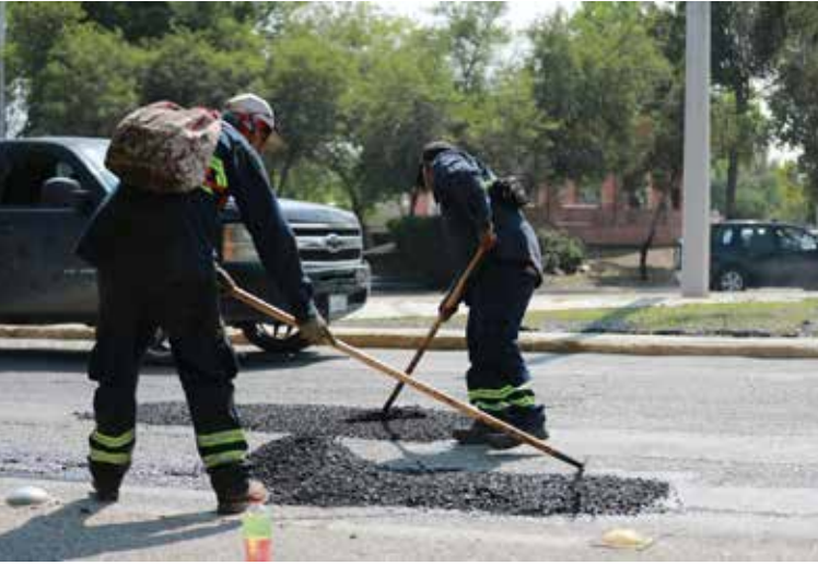
BRIGADAS MUNICIPALES REHABILITAN tramos deteriorados en vialidades principales como Francisco Coss, Isidro López y la zona universitaria.
