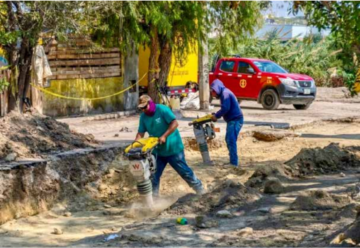
EL AYUNTAMIENTO PIDE paciencia a conductores y peatones ante los cierres temporales generados por la sustitución de líneas de drenaje en la zona.
