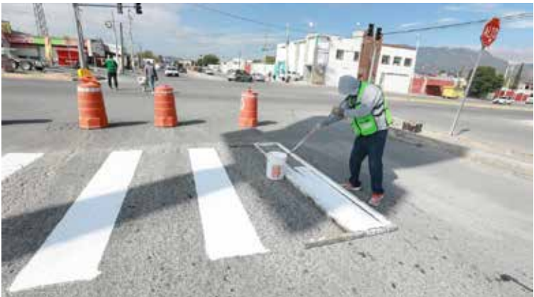
LAS LABORES DE recarpeteo preventivo y pintura de carriles pretenden brindar mayor seguridad y fluidez a los automovilistas.
