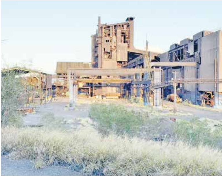
EN AHMSA, EL presupuesto en millones de dólares para mantenimiento y rehabilitación calculado por Organización Levin, destaca que para Laminación en Frío 1, se requiere la cantidad de 5.8 millones.
