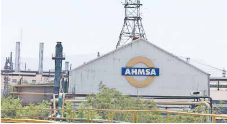
NO HAY PERSONAS detenidas por robo de breakers en AHMSA.
